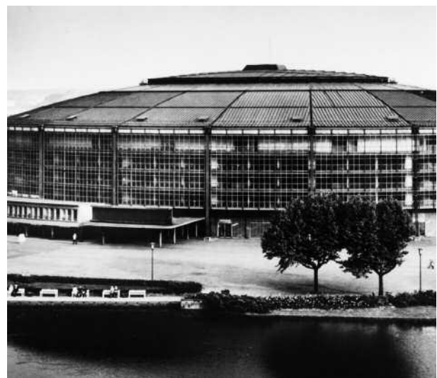
Wie einwandfrei sich unbehandelte Aluminiumoberflächen gegenüber Witterungseinflüssen verhalten, zeigt zum Beispiel das Dach der Westfalenhalle Dortmund (Baujahr 1952). (Bild 1)
